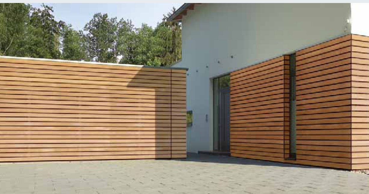
Poszycie z paneli drewnianych wykonane przez inwestora
